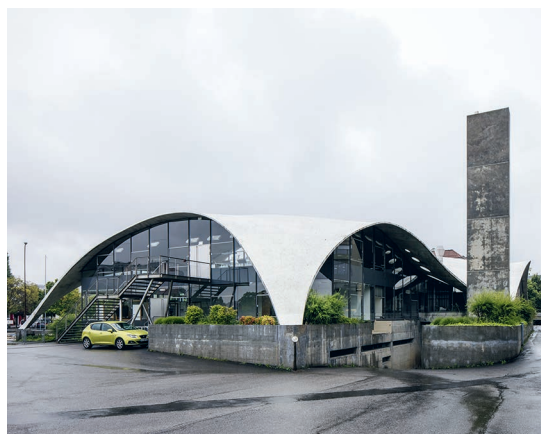
Pavillon Sicli. Utilisation du béton en voile mince. Construit entre 1966 et 1970 par l'ingénieur Heinz Isler et l'architecte Constantin Hilberert.
