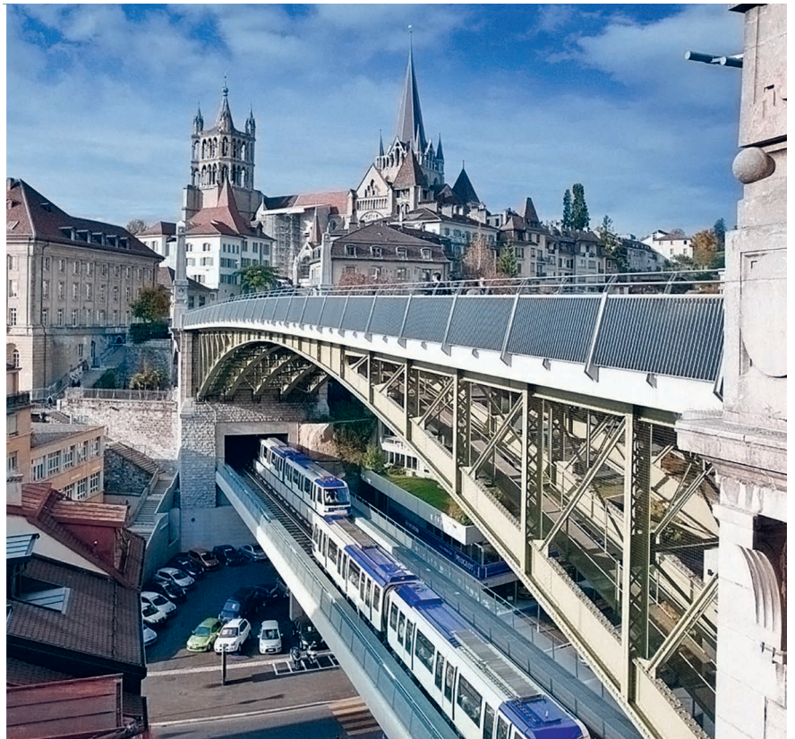
Le Pont Bessière à Lausanne, inauguré en 1910, est un bel exemple d'ouvrage d'art dont le tablier est supporté par cinq arcs en acier prenant appui sur des culées en pierre.
