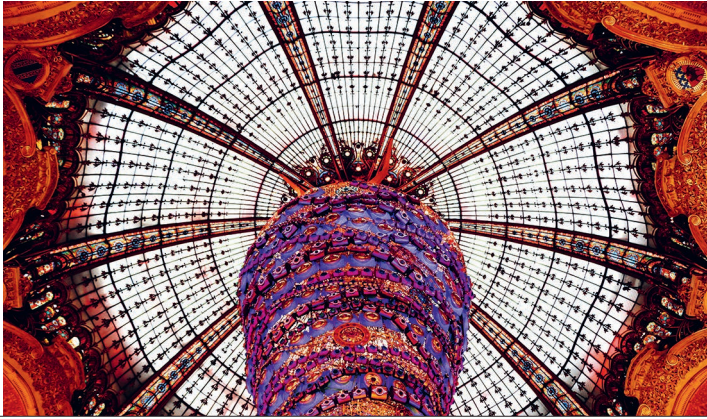
Coupole des Galeries Lafayette. Paris. Dôme en acier, avec une couverture en verre.
