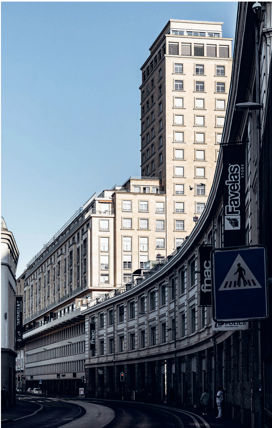
Tour de Bel-Air à Lausanne, achevée en 1931, conçue sur le modèle américain : socle en béton, structure porteuse en acier, façade en pierre.
