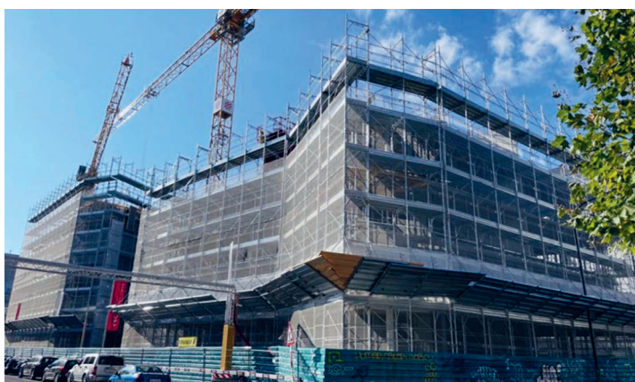
Vue du chantier Les maraîchers à Genève
