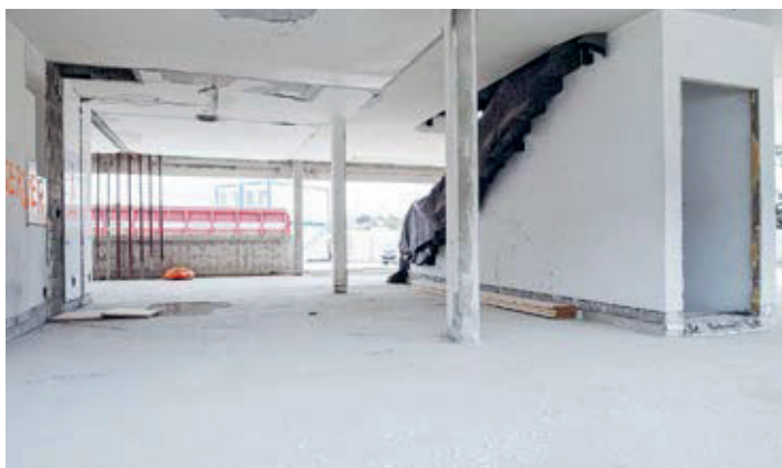
Les éléments structurels intérieurs du bâtiment en cours de transformation ont été conservés.
