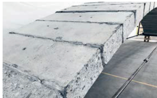
Mortiers aux joints pour combler les différences dimensionnelles et assurer le bon contact entre les différents blocs.
