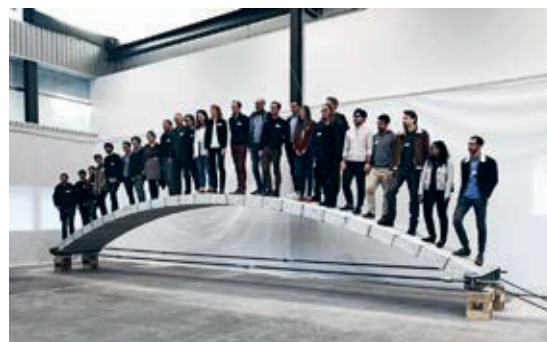
L'ouvrage a une portée de 10 m. Lors de l'inauguration, 25 personnes sont montées dessus.
