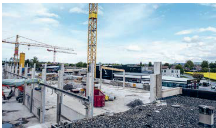
Vue générale du chantier. Sur la gauche, le bâtiment en cours de reconstruction avec les éléments de façade réemployés.
