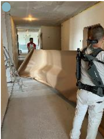
1- mise en place des protections
