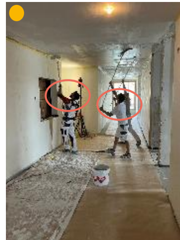
3- application de la 1ère couche d'enduit
