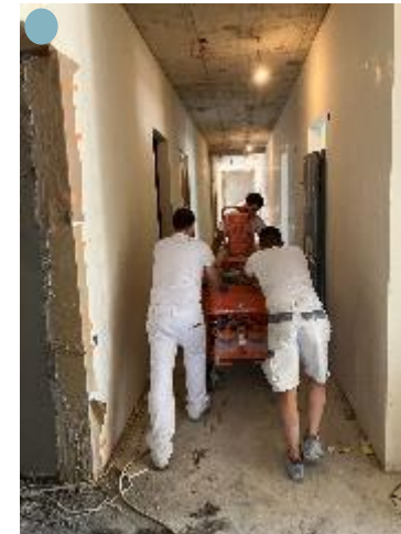
5- nettoyage et déplacement de la machine
