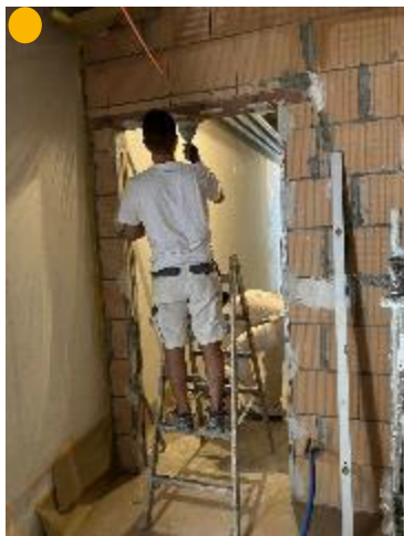
1- pose de baguettes
