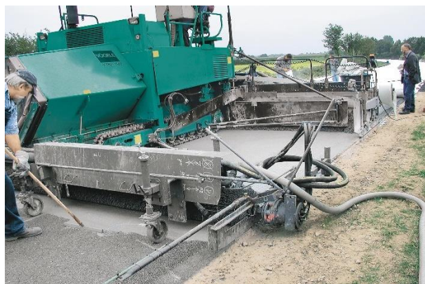
FINISSEUSE A BETON - RADIER - ROUTE
