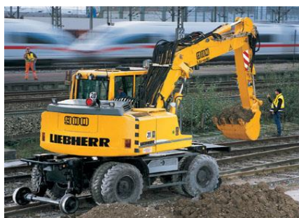
PELLE SUR RAIL (+ FORMATION CFF)
